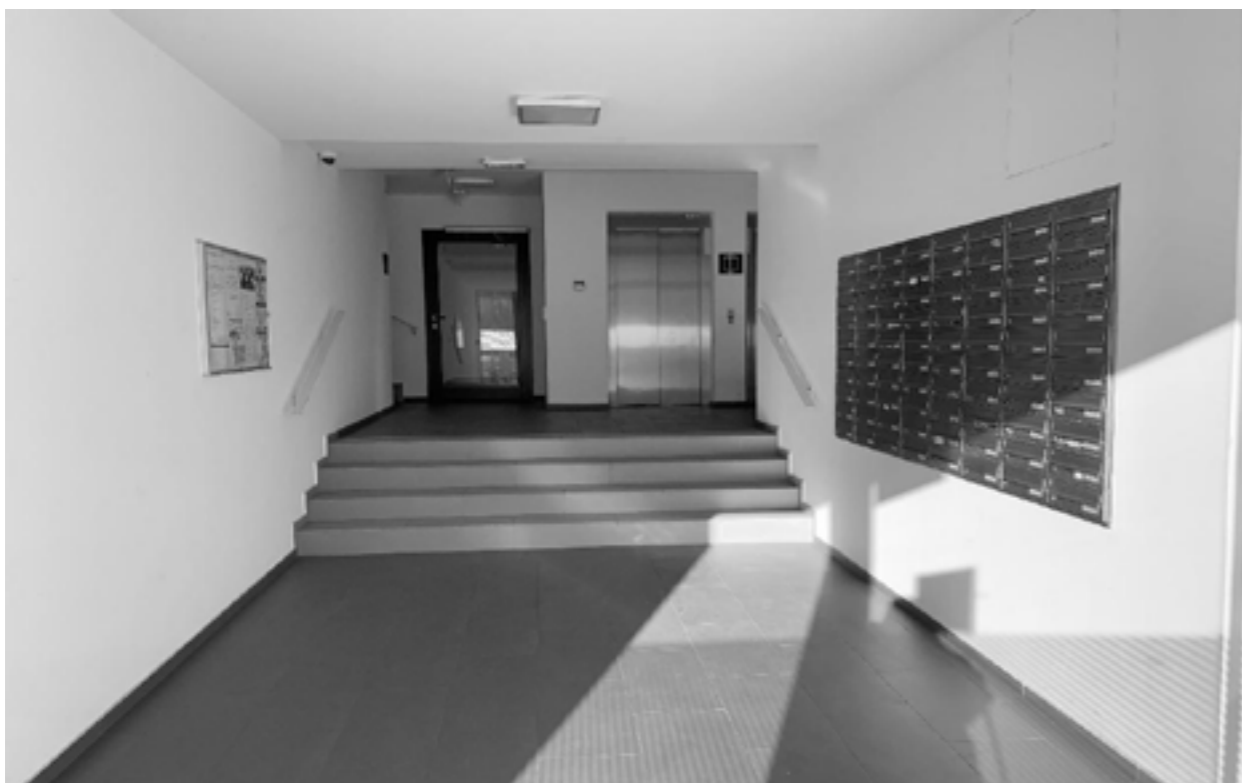
Obr. 5 Bytový dom, Bratislava – interiér (schodisko k výtahom bez rampy, jediný bezbariérový prístup je situovaný z vnútrobloku, ktorý je mimo dopravnej komunikácie)
