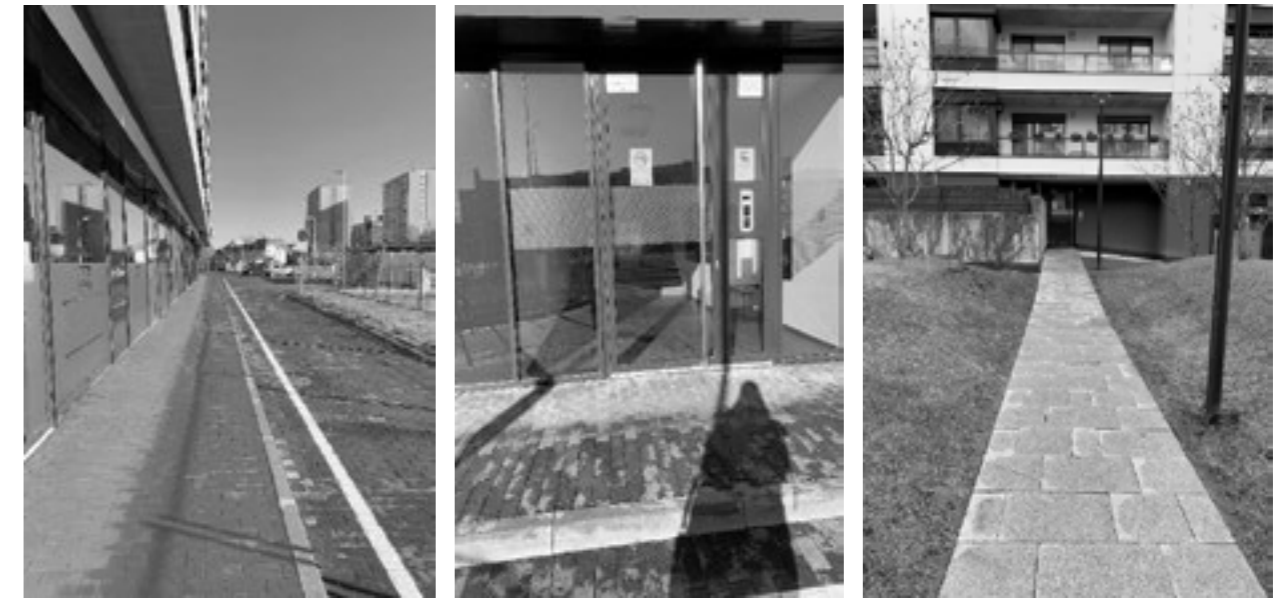
Obr. 6,7,8 Bytový dom, Bratislava – exteriér (prístupová komunikácia a prvá bariéra vo forme obrubičnika, druhá bariéra sú ťažké vstupné dvere a v interiéri schodisko k výtahom bez rampy, vstup z vnútrobloku ako jediná vhodná prístupová cesta k výtahom)
