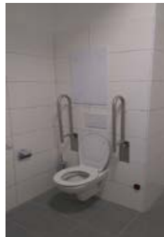
obr. 2 bezbariérová toaleta so sklopnými držadlami v bezbariérovej ubytovacej bunke Študentského domova Jura Hronca
