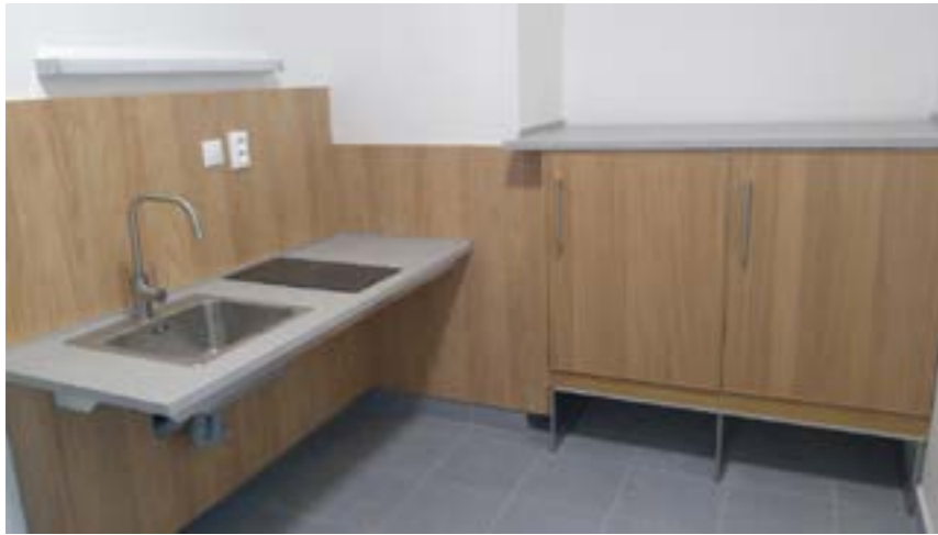
obr. 1 bezbariérová kuchynka s priestorom na zasunutie nôh osoby na vozíku pod drezom a varnou doskou v bezbariérovej ubytovacej bunke Študentského domova Jura Hronca
