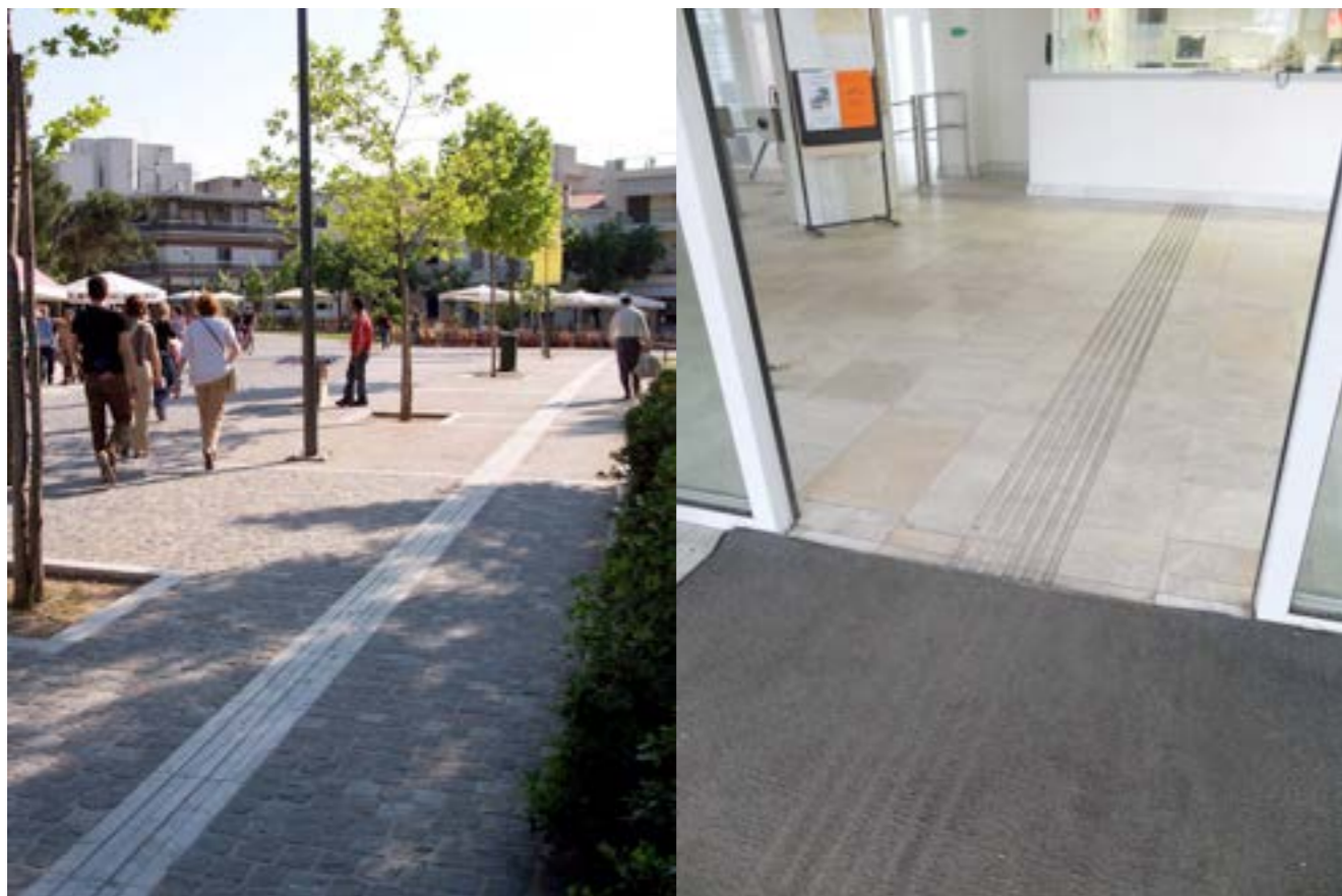
Obr. 8 Umelé vodiace línie môžu byť použité v exteriéri aj interiéri na miestach, kde nie sú dodatočné prirodzené vodiace línie
