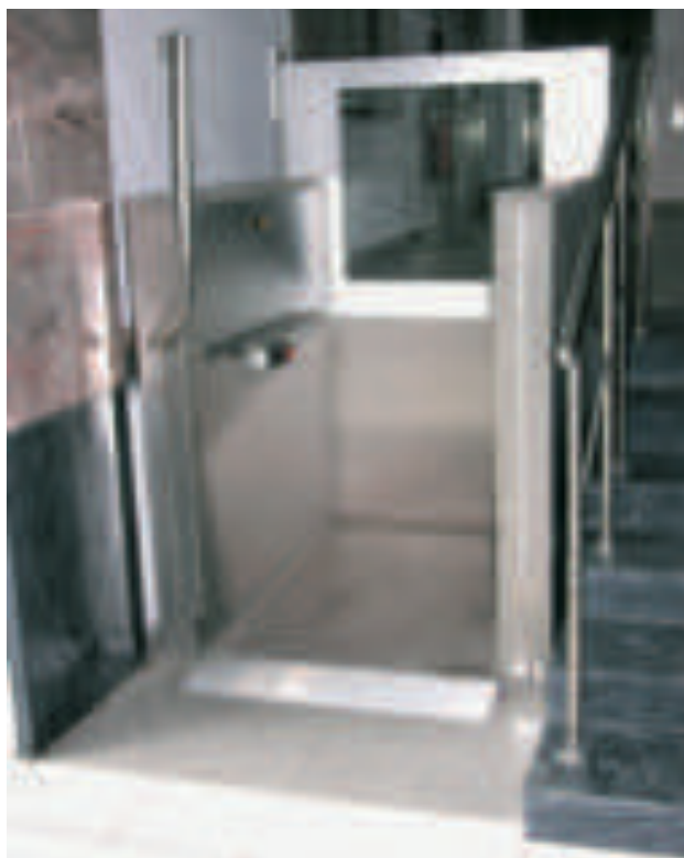
Obr. 2e: Zvislá zdvíhacia plošina je aj v interiéri pohodlnejšia ako šikmá schodisková plošina.
