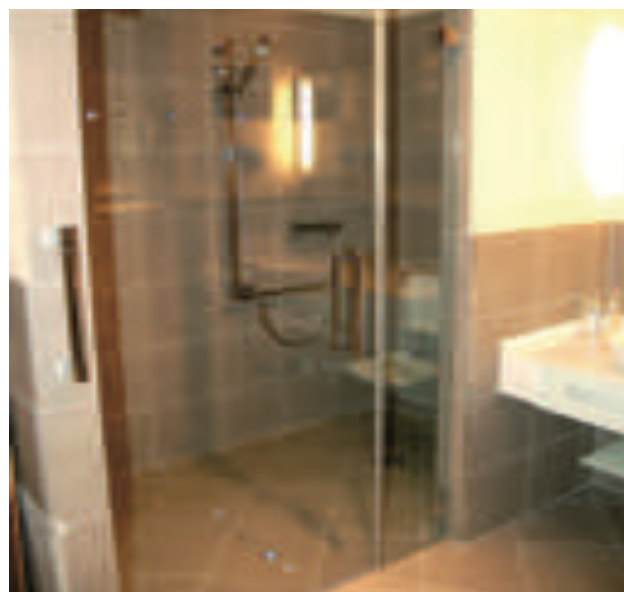
Obr. 3a, 3b. Príklad riešenia bezbariérovej sprchy, ktorá je odvodnená do podlahového vpustu alebo odtokového žlabu. Takto riešená sprcha je komfortná pre každého klienta.
